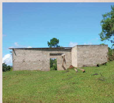
Igreja: Construção interrompida
